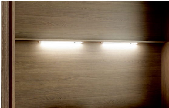
Led 25 - zwei einzeln einschaltbare Lampen mit integriertem Switch und Dimmer Funktion. LED hochkant in Ecken montiert.
